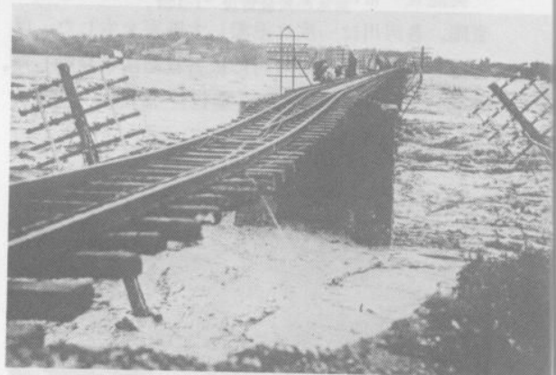
写真②-4-2 昭和9年 洪水で流失寸前の手取川鉄橋
