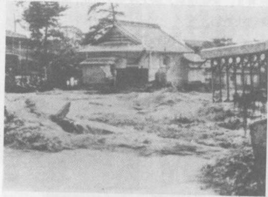
写真②-4-1 大正11年 洪水で痛めつけられる川除町の民家
