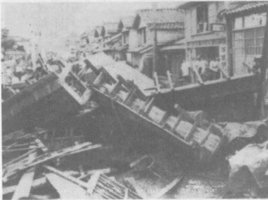
写真②-4-3 昭和33年 輪島市内水害の跡
